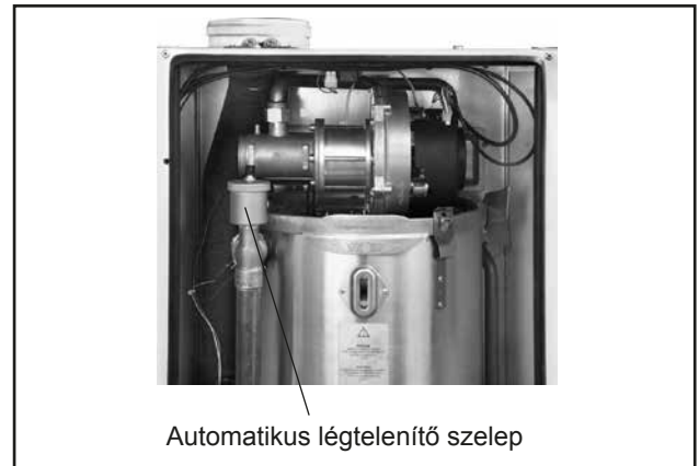
Ábra: Automatikus légtelenítő szelep
